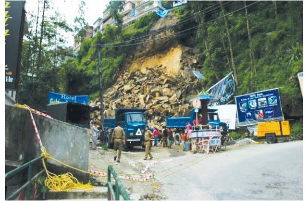
चित्र 67. अमडो गोलाई, टाडोंग, गंगटोक पर भारी चट्टानों का गिरना और भवनों को खाली करना
